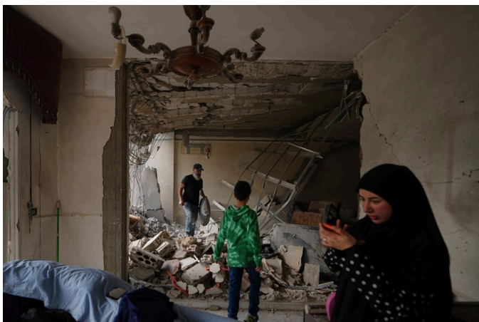
Une famille fouille les décombres de sa maison fortement endommagée par des frappes israéliennes dans la banlieue sud de Beyrouth, au Liban, le 25 avril 2026 — Photo Hassan Ammar/AP/Sipa.
